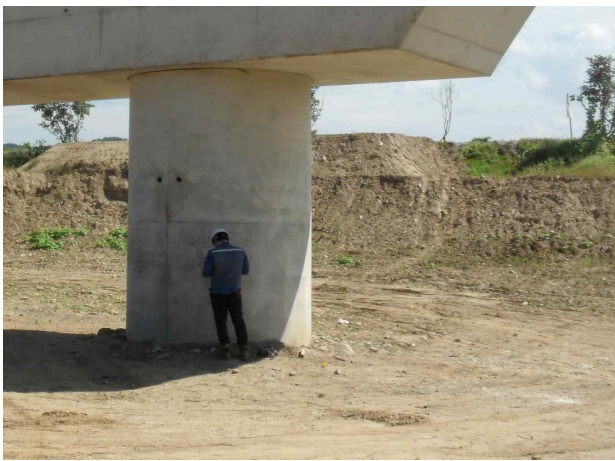
의상대교 P2 외관조사 전경
