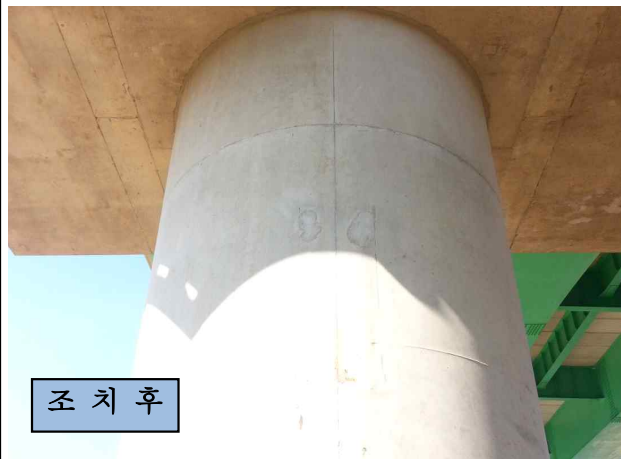
<P10 앵커홀 주변 콘크리트파손 보수완료>
