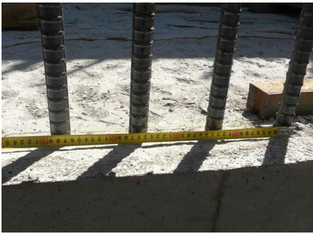
의상대교 A1 철근간격 측정
