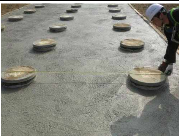
의상대교 A2 기초 강관파일 간격측정
