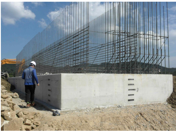
의상대교 A2 외관조사 전경
