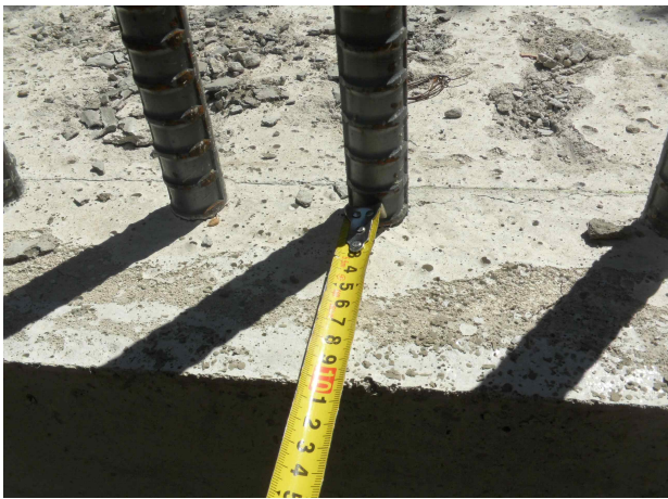
의상대교 A1 철근간격 측정
