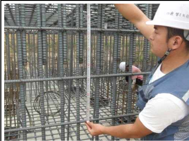
의상대교 A1 기초부 철근간격 측정
